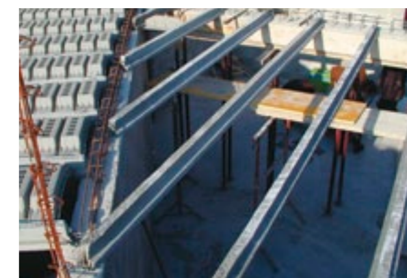
▲ 4-Pose des poutrelles
