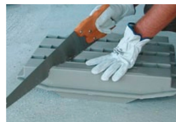
▲ 2-Méthodes de coupe : scie égoïne ou scie circulaire
