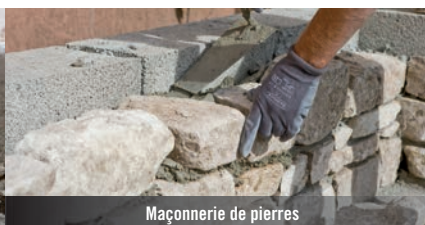
Maçonnerie de pierres
