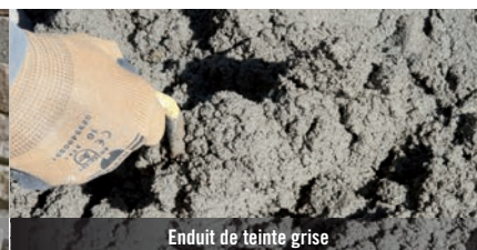
Enduit de teinte grise
